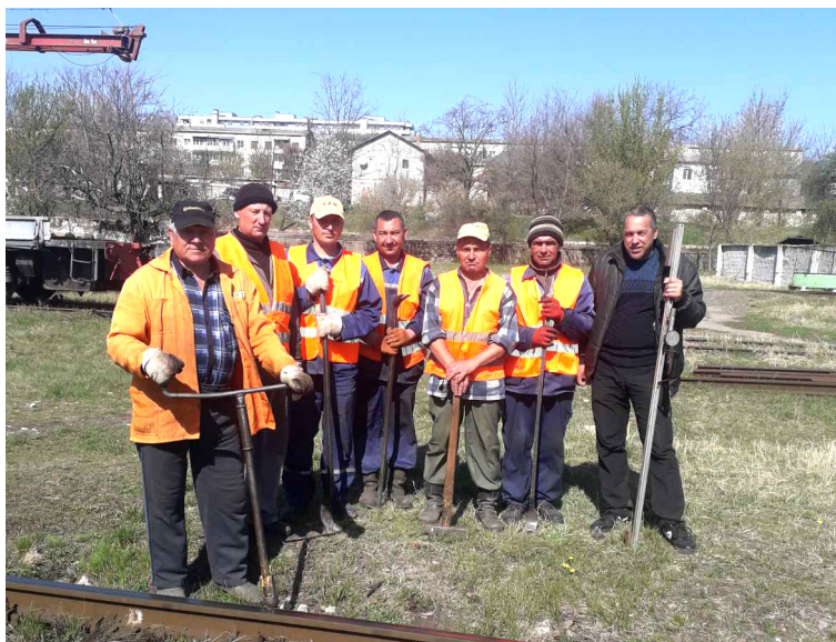
Монтеры пути 10-го околотка, которым руководит бригадир пути О.Баксан, заняты перешивкой пути на станции Унгены
