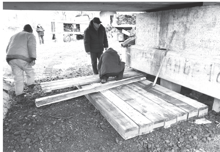
Восстановление опоры моста 1539 км перегона Мерены—Ревака работниками МП-1
