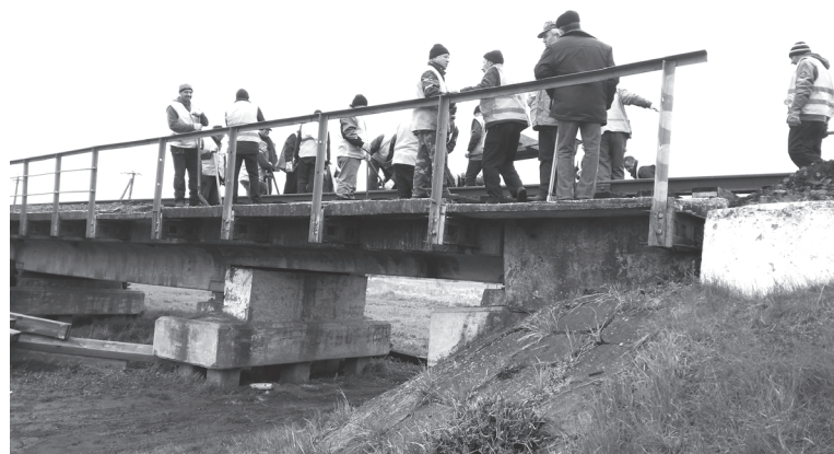
Работники ПЧ-2 производят капитальный ремонт моста 1539 км, перегон Мерены—Ревака
