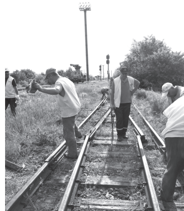
Работники ПЧ-2 на восстановлении пути № 7 ст.Кэушень
