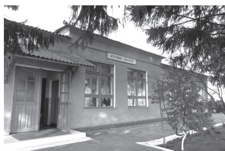
Vedere asupra stației Brătușeni
